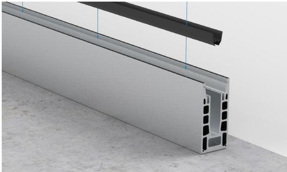
2. Unteres Verglasungsprofil einsetzen (im Außenbereich an den bauseitig hinzugefügten Entwässerungsbohrungen aussparen)
